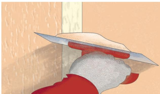
8. После перерыва малярная клейкая лента наклеивается на край ранее нанесенной штукатурки и снимается после нанесения стыковочной полосы декоративной штукатурки.
