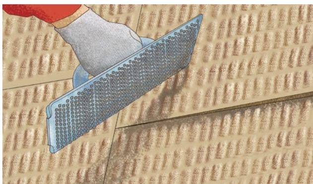
16. Смонтированные плиты должны находиться в одной плоскости. В случае обнаружения неровностей (не более 2-4 мм) на поверхности их следует отшлифовать специальной теркой. Выравнивание неровностей за счет увеличения толщины базового армировочного слоя не допускается.
