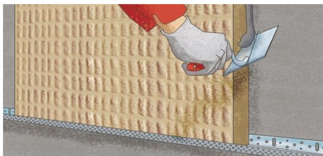
7. Излишки клея после приклеивания плит следует удалить с помощью шпателя. Оставлять клеевой состав на торцах плит не допускается.
