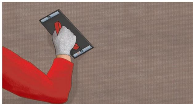
6. Поверхность смонтированного базового штукатурного слоя не должна иметь неровностей. Перепады на длине поверхности в 1 метр не должны превышать величину, соответствующую максимальной величине зерна декоративной штукатурки (плюс 0,5 мм), которая наносится следующим этапом. Все неровности должны быть удалены путем шлифования поверхности.
