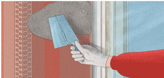
5. Далее в этот профиль заводится армирующий слой РОКмортар с сеткой от армирующего уголка. Если сетки от армирующего уголка и профиля примыкания недостаточно для перехлеста, необходимо вырезать полосу сетки РОКфайбер-Б для обеспечения полного армирования откосов и их угловых частей.
